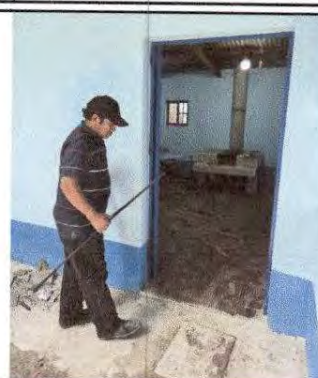
Foto 2: Sustitución de puerta.
