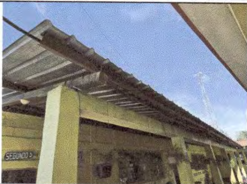
Foto7: Sustitución de canales de PVC y bajada de agua pluvial.
