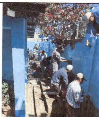
Foto 9: Pintura en muros exteriores.
