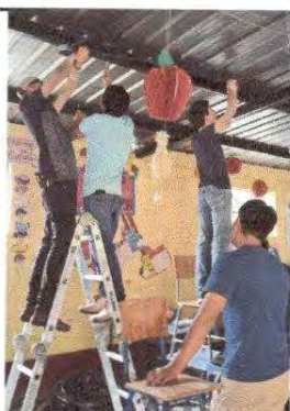
Foto 15: Reparación de cableado eléctrico
