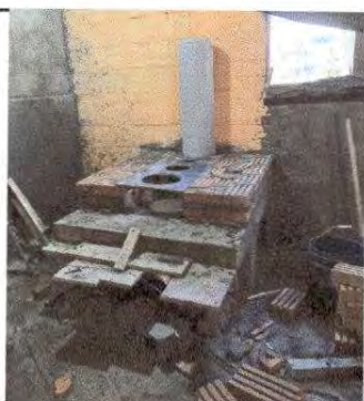
Foto 17: Sustitución de estufa rural (completa) incluye chimenea y plancha de metal. Instalación de azulejo en estufa rural.
