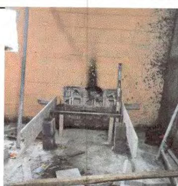
Foto 16: Sustitución de estufa rural (completa) incluye chimenea y plancha de metal. Instalación de azulejo en estufa rural.
