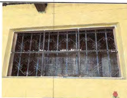
Foto 4: Sustitución de vidrios.
