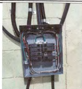
Foto 14: Sustitución de talbero de flipones.
