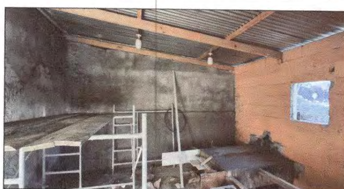
Foto 18: Repello en muro.
