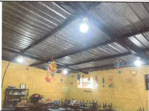
Foto13: Sustitución de focos ahorradores.
