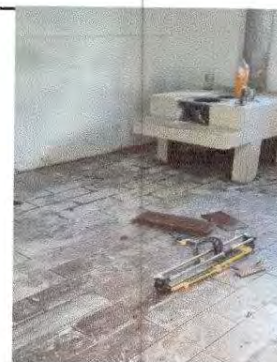
Foto 6: Sustitución de piso ceramico.
