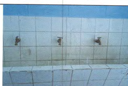
Foto 12: Sustitución de llave de chorro.
