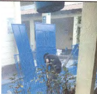
Foto1: Mantenimiento a estructura (lijado, cambio de tubo, cepillado, sujecioens, aplicacián de pintura).
